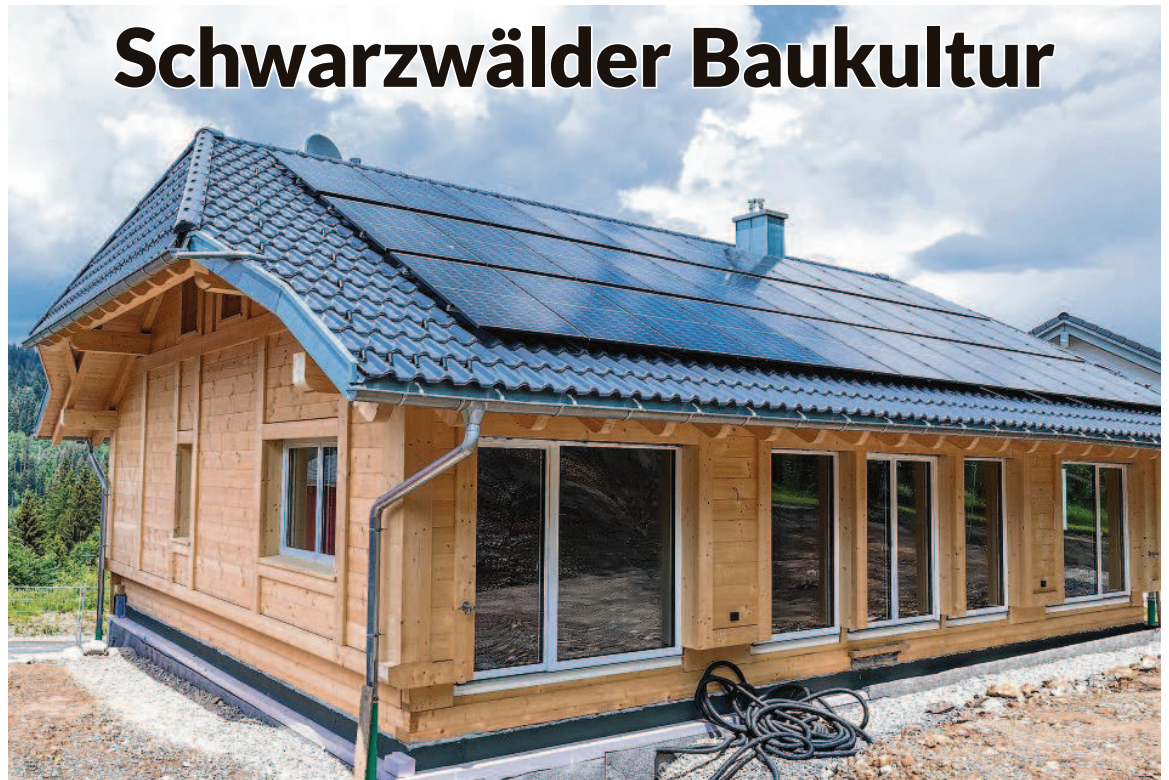
Ein Walmdach und schwarzwaldtypische Architektur zeichnen die Ständer-Bohlen-Häuser von Holzbau Bruno Kaiser aus. Durch großflächige Fenster und Glastüren kommt viel Licht in die Wohnräume. Bild: Holzbau Bruno Kaiser GmbH/Martin Granacher
