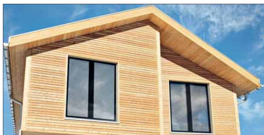
Von außen sind bei dem Holz-Aluminium-Fenster keine Aluminiumprofile sichtbar, auch nicht bei zweiflügeliger Ausführung. Fotos: Ego Kiefer
