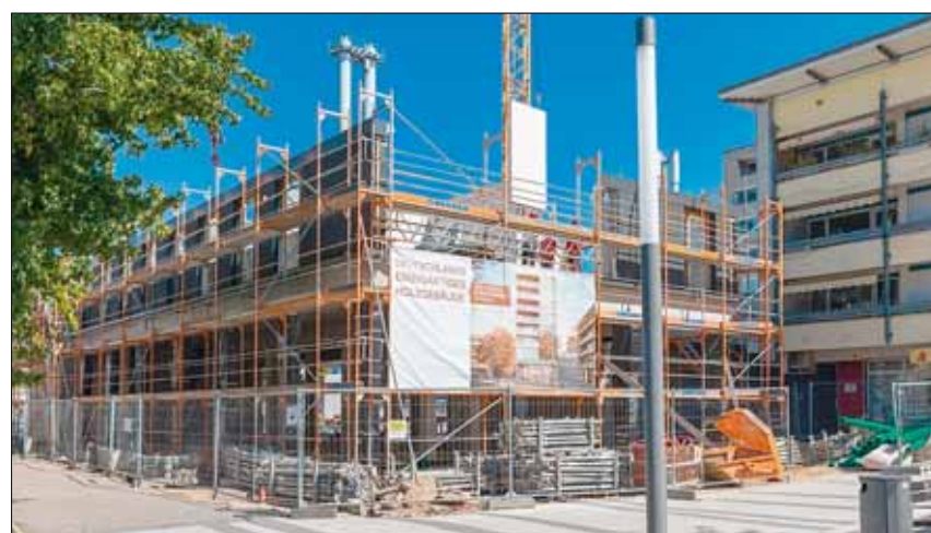
Ende August begann das Aufrichten des Holzbaus in der Buggingerstraße.
