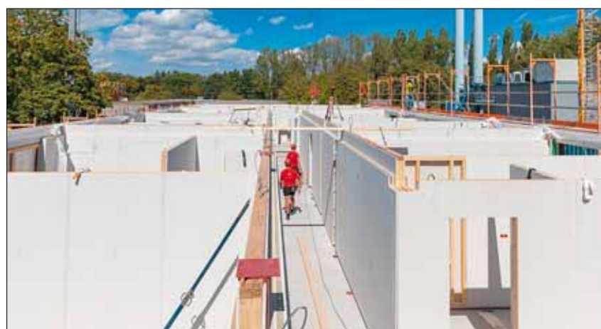
Auch die Wohnungstrennwände entsprechen durch die beidseitige doppelte Beplankung mit Gipsfaserplatten dem Kapselkriterium K 2,60 . Fotos: Bruno Kaiser
