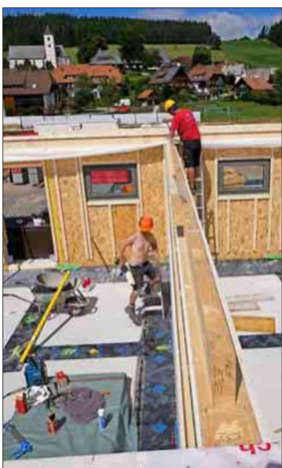
Eine Wohnungstrennwand von oben
