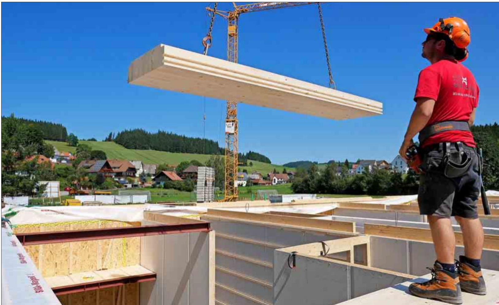
Und schon fliegt das nächste Holzdeckenelement ein (links), das an speziellen Haltevorrichtungen des Krans (rechts) für die Decken- und Wandelemente befestigt wird.
