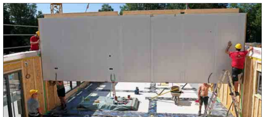
Die nächste Innenwand wird gesetzt.
