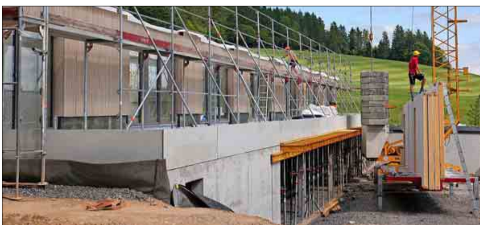
Das Erdgeschoss stand innerhalb einer Woche.
