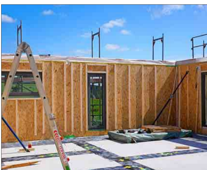
Nach nur einem Tag standen die Außenwände (links), ein Laster bringt die Holzelemente (Mitte), in der Ortschaft weist ein Schild den Weg zur Baustelle (rechts).
