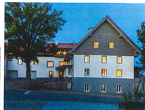
▲ In den Dachgeschossen schützt eine Holzfaserdämmung vor Hitze und Kälte
