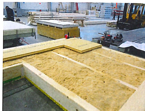
▲ Vorfertigung, Einbringung der losen Holzfaserdämmung und Schließung des Gefachs
