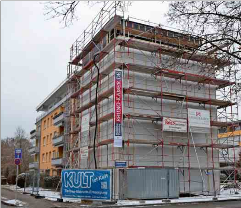
Mittlerweile gut verpackt steht das Holzhaus in der Haager Straße, das mit vorgefertigten Elementen rasch in die Höhe wuchs. Derzeit läuft der Innenausbau des Gebäudes.
